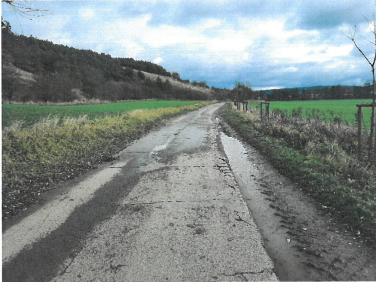
Cesta na Železné, pohled směrem k Drásovu
