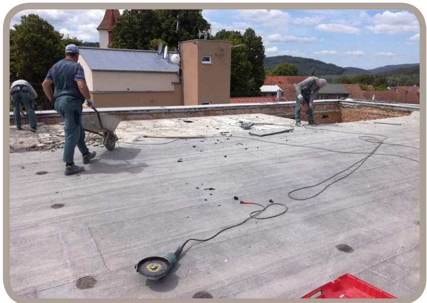
Bourací práce na střeše
