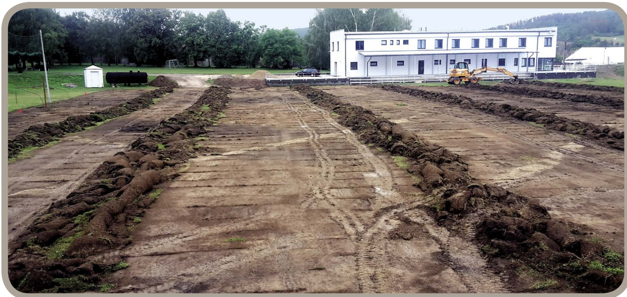
Rekonstrukce hřiště – úpravy odvodnění (nahore) a skrývka původního povrchu (dole)
