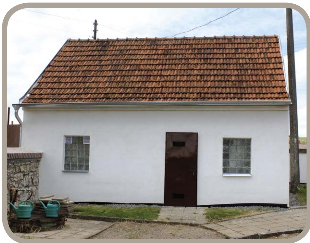
Oprava kamenné zdi na drásovském hřbitově a oprava márnice
